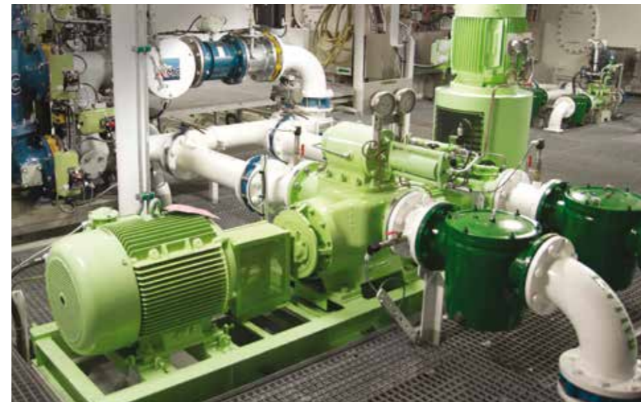
Rensesystem for ballastvann installert om bord på Esvagt Faraday. Foto: Gunnar Larsen
